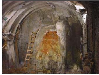
Fundación y pozo encontrado durante las excavaciones
